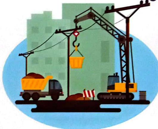
Hindari membangun/memperbaiki bangunan dekat jaringan listrik jarak aman minimal 3 meter.
